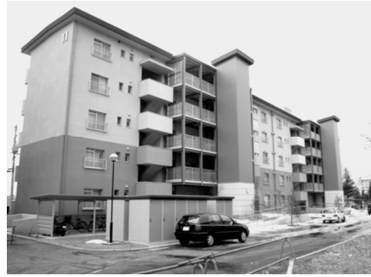
図 9 鉄骨造片廊下が増築された例
