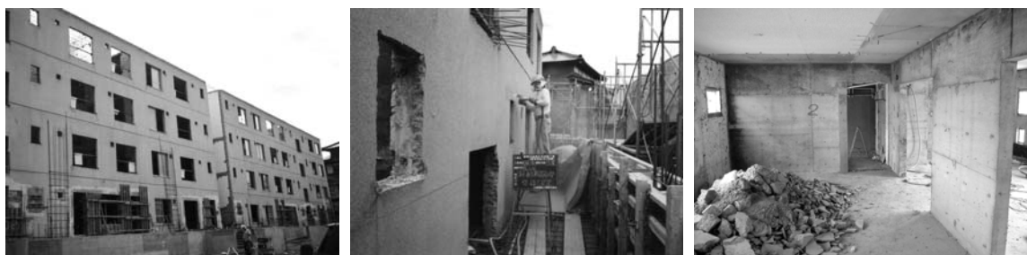
図 11 大規模改修工事の状況
