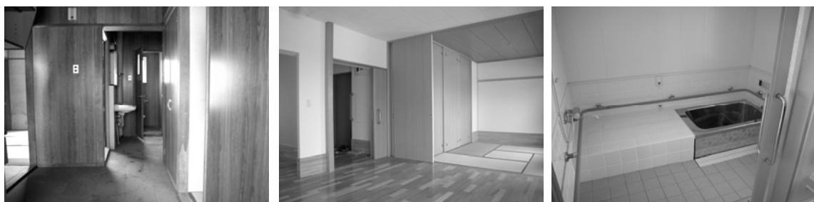
図 10 内装の一新が行われた住戸（左：改修前，中央：改修後，右，改修後の車椅子対応浴室）
